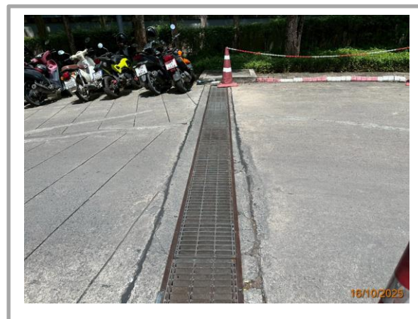
รูปที่ 3.1-17 ตะแกรงดักขยะบริเวณระบายน้ำออก ภายนอกโครงการ
