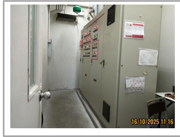
รูปที่ 3.1-25 ตู้ควบคุมระบบบำบัดน้ำเสีย
